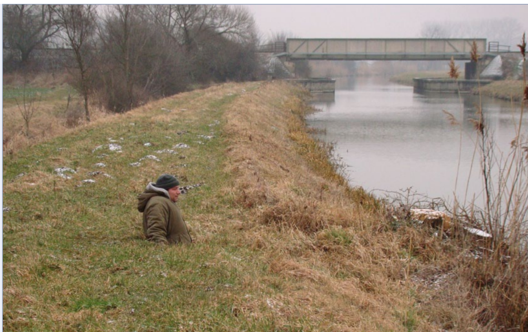
Bild3 / Eingebrochene Biberrohre können sehr tief sein und komplizieren die Uferpflege
