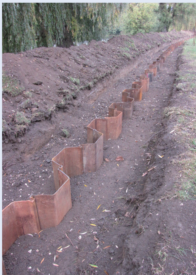
Obr. 5 / Realizace podzemní štětové stěny
