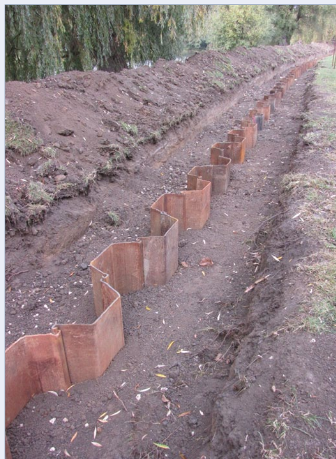
Obr. 5 / Realizace podzemní štětové stěny Bild 5 / Umsetzung der eingerammten Spundwand
