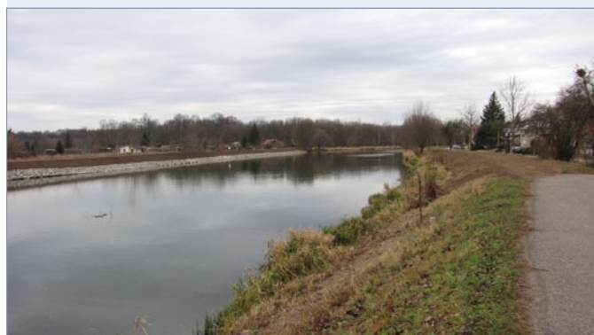
Obr. 4 / Celkový pohled na lokalitu Bild 4 / Gesamtanblick des Standorts
